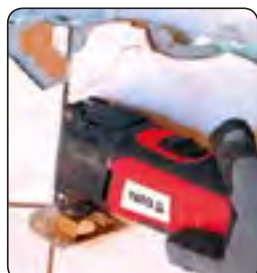
przecinanie glazury, wymiana pękniętych płytek i silikonów
